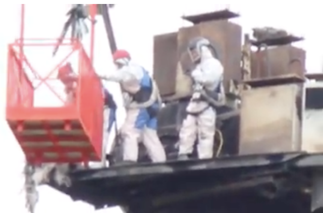
Rückbau im Vollschutz
